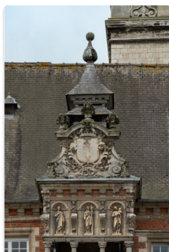
Armoiries du royaume de France sculptées au sommet de la bretèche de l'hôtel de ville en 1702. © PhotoStopper
